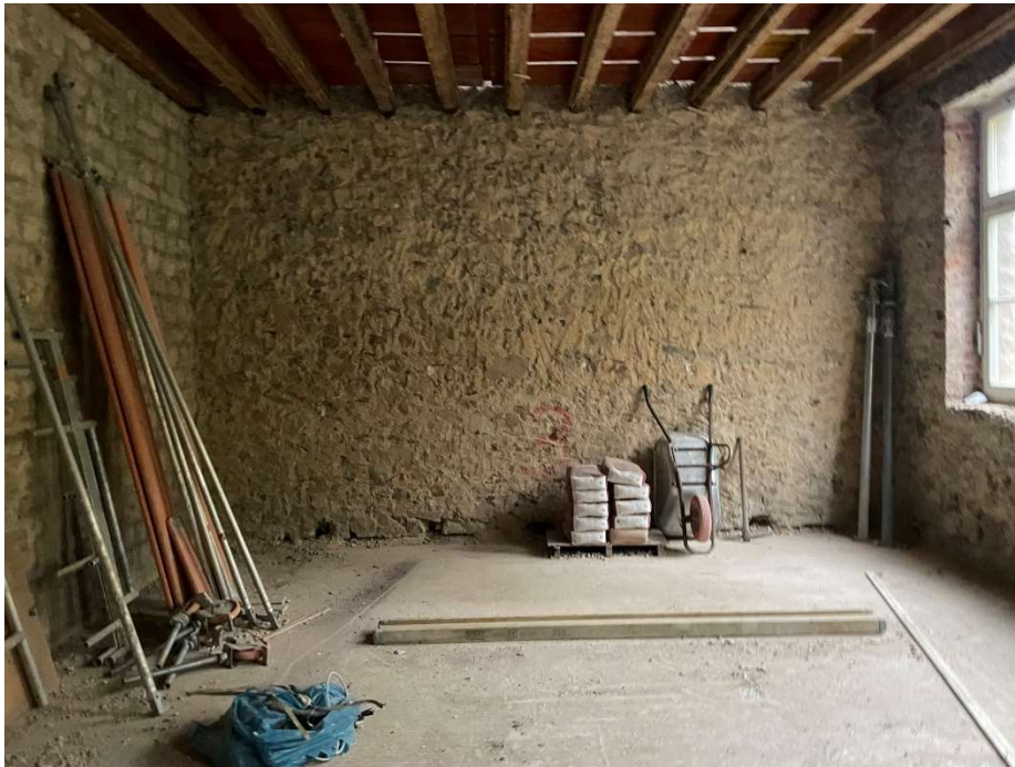
Innenansicht der Bruchsteinwände, Baustellensituation nach Demontage Innenputz
