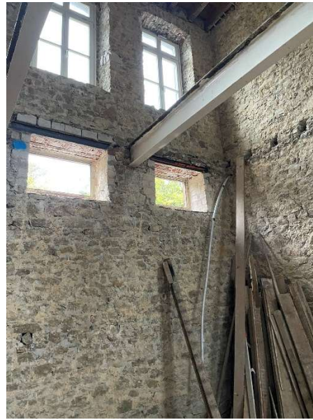
Innenansicht der Bruchsteinwände, Baustellensituation nach Demontage Innenputz
