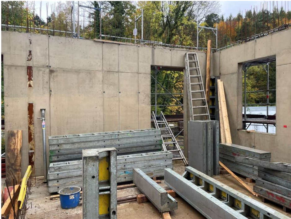
Innenwände im Neubau, ausgeschalter Stahlbeton, Baustellensituation
