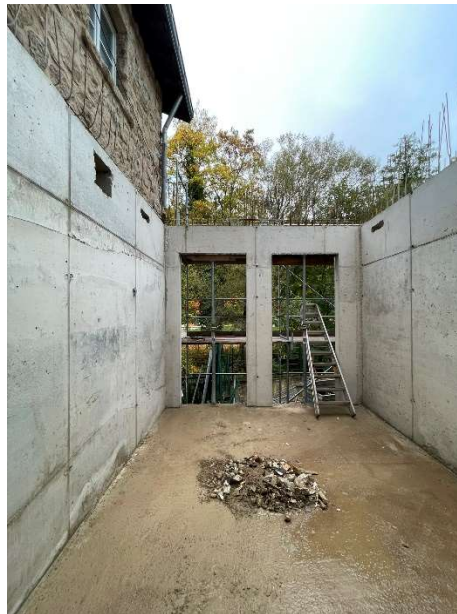
Innenwände im Neubau, ausgeschalter Stahlbeton, Baustellensituation
